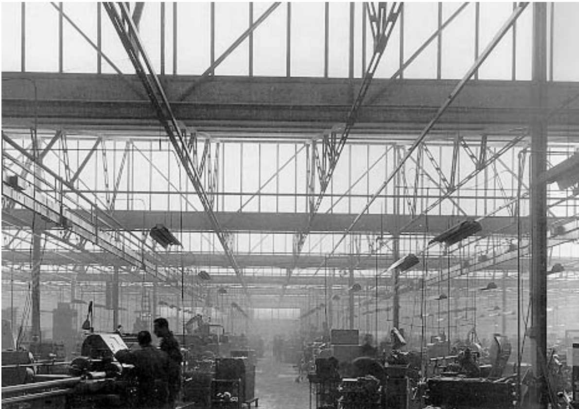
Interior de la fàbrica Montesa d'Esplugues de Llobregat. Font: Col·legi d'Arquitectes de Catalunya
