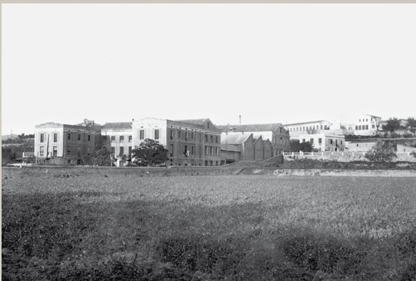
Vista general del complex industrial de Can Vilumara, la primera fàbrica tèxtil instal·lada a Cornellà l'any 1851 Fotografia: Arxiu Històric de Cornellà de Llobregat
