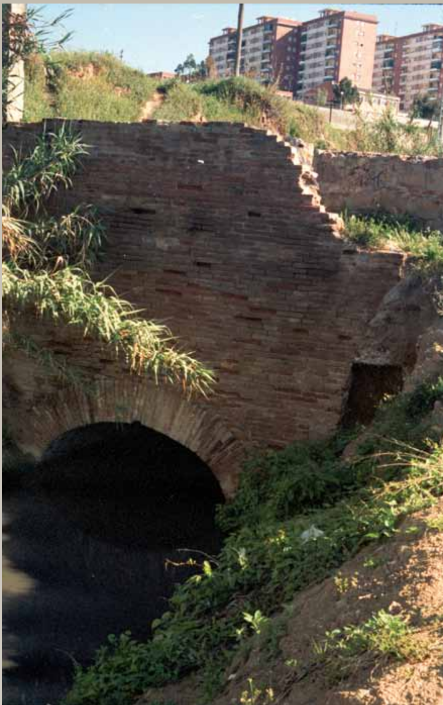
Imatge del pont Quitllet encara en utilització, poc temps abans de la desaparició del Canal. El pont encara avui es pot contemplar. Fotografia: Blai Cardat
