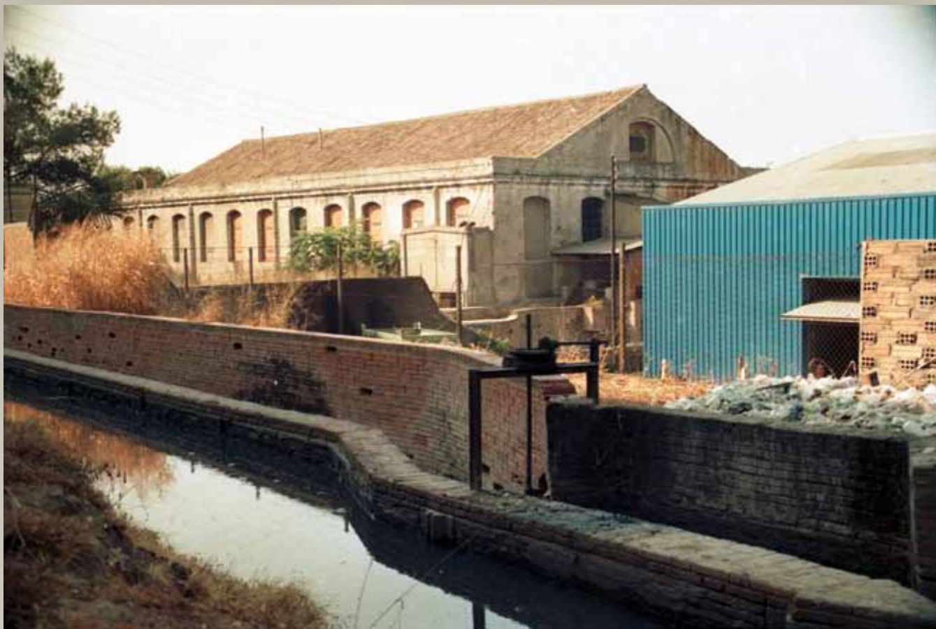
Desviament i conducció de l'aigua del Canal per a ser conduïda al salt d'aigua de la fàbrica, poc temps abans de la seva desaparició. Fotografia: Blai Carda
